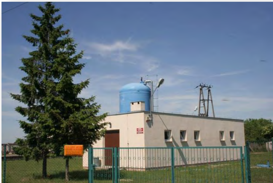
FOTOGRAFIA 7. STACJA WODOCIĄGOWA DUSZNIKI
