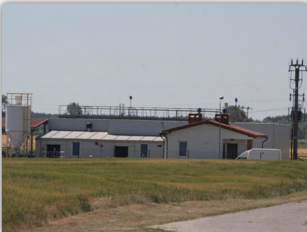
FOTOGRAFIA 9. OCZYSZCZALNIA ŚCIEKÓW W DUSZNIKACH
