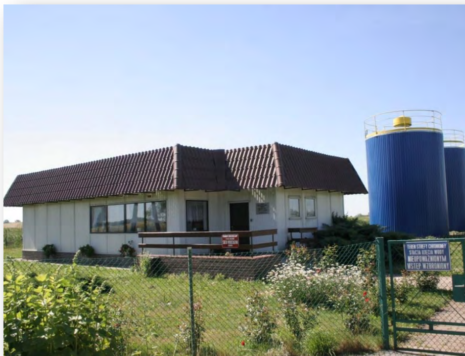
FOTOGRAFIA 8. STACJA UZDATNIANIA WODY KUNOWO
