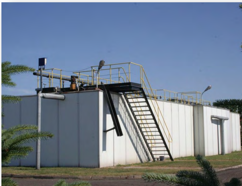
FOTOGRAFIA 10. OCZYSZCZALNIA ŚCIEKÓW PODRZEWIU
