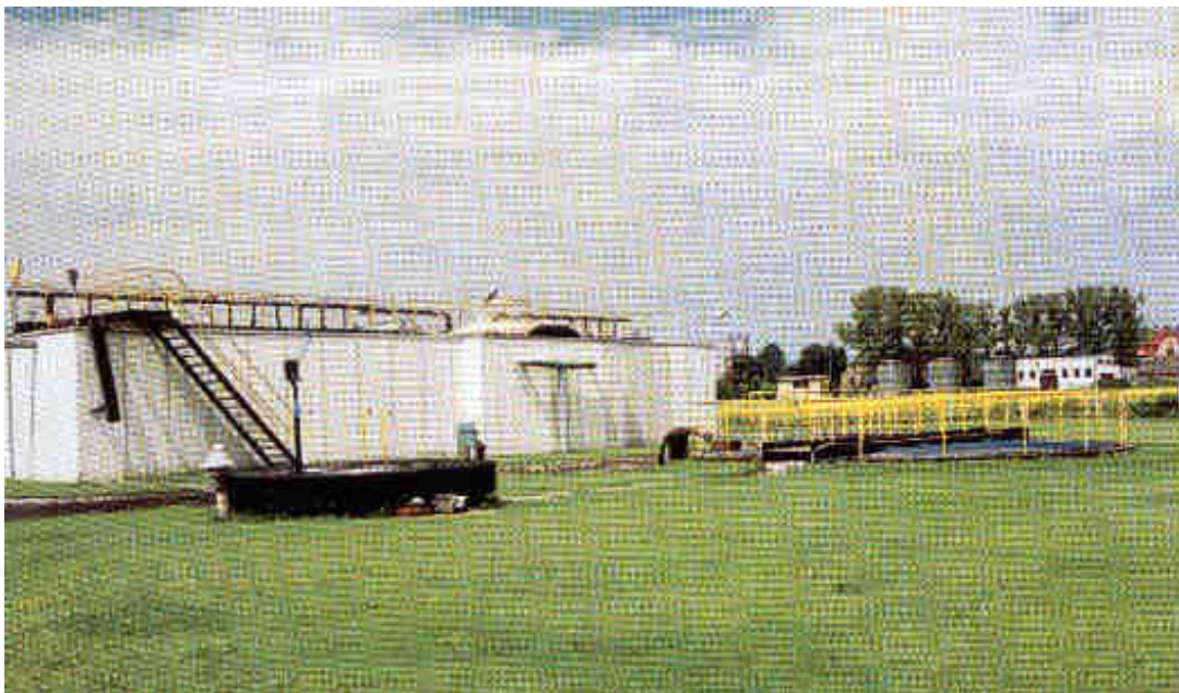
Oczyszczalnia ścieków w Podrzewiu
